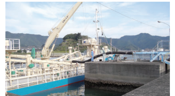
圧送ホース吊下げ状況 Unloading
