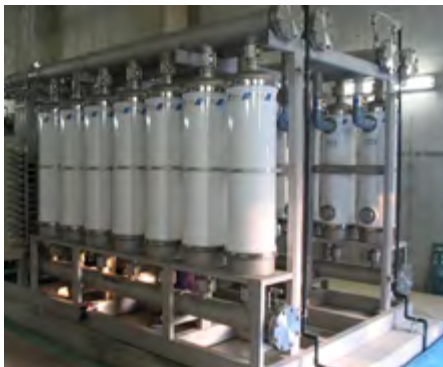
簡易水道用UF装置
